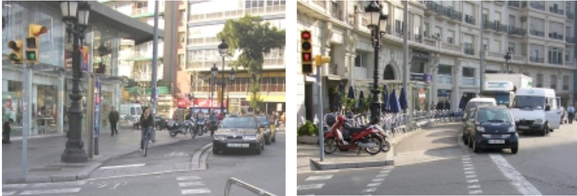
Foto 2. Carril bici en plataforma, reduïnt la calçada i ampliant la vorera, a Barcelona: plaça Francesc Macià
