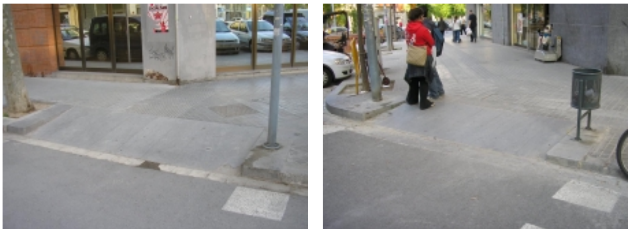
Foto 11. Gual de vianants tipus 120 adaptat amb protecció dels desnivells laterals (amb semàfors, papereres, arbres, senyals de trànsit), el gual barceloní
