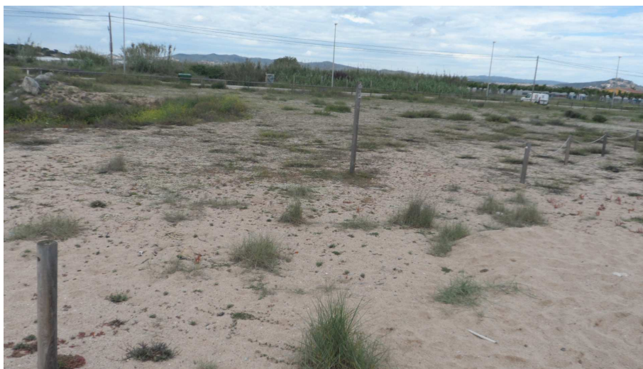
Foto 1. Al TN1 manquen diversos segments de corda així com la placa de normes de conducta
