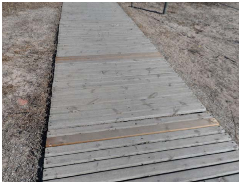
Foto 1. Les travesses malmeses de les passeres han estat substituïdes diligentment, bo i fent bona la tasca de manteniment del mobiliari
