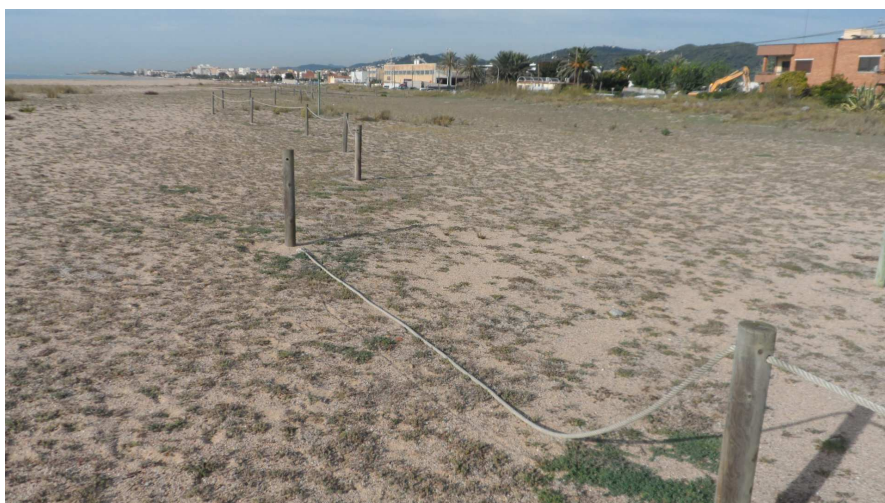
Foto 5. A l'extrem nord de TS3 falta un segment de corda i el consecutiu és a terra
